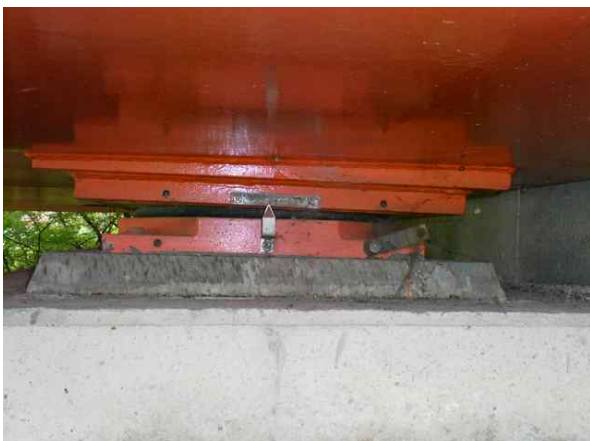
받침장치 가동량 측정
