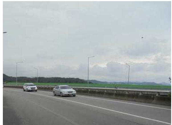
난간 및 연석 상태양호
