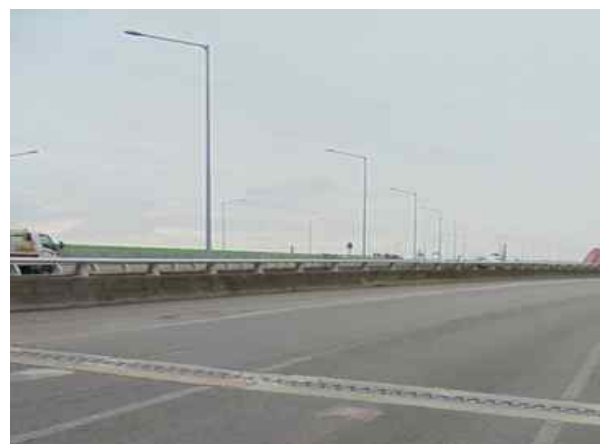
난간 및 연석 상태양호
