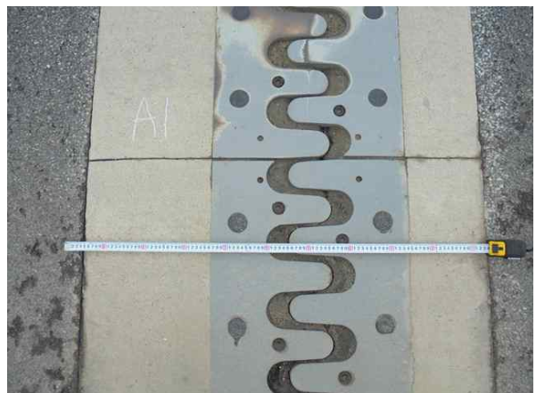
신축이음 이동량 측정
