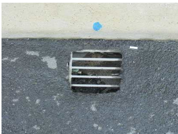
배수구 상태 양호 - 금회
