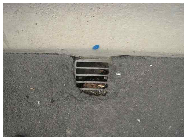
배수구 상태 양호 - 21년 하반기
