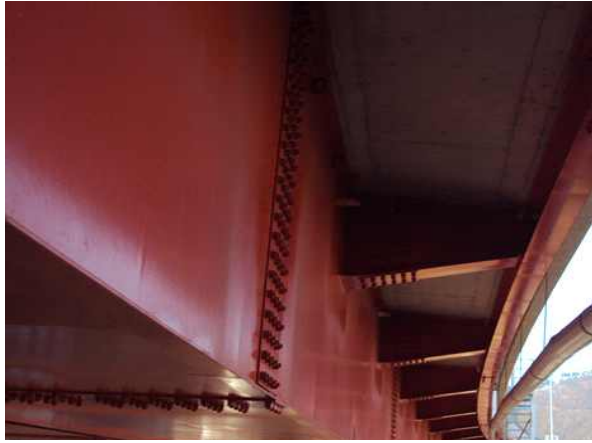
바닥판 하면 상태양호
