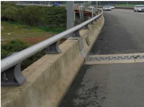
난간 및 연석 상태양호
