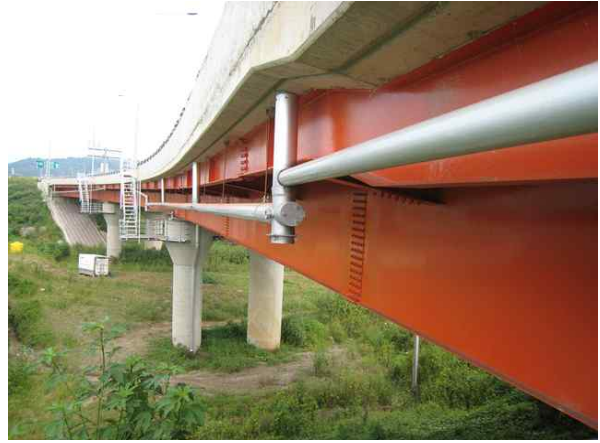
바닥판 하면 상태양호
